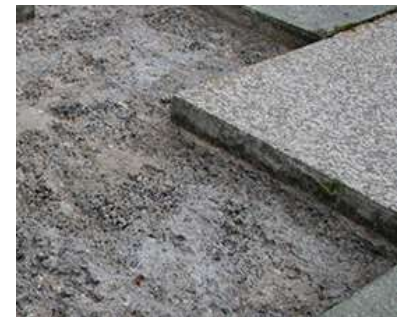
Abbildung 25: teilweise entfernte Bodenplatten Quelle: Kaleta 2020
